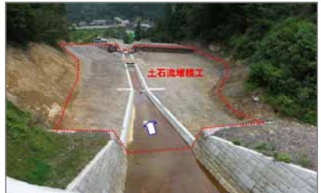
不透過型砂防堰堤・土石流堆積工の設計
