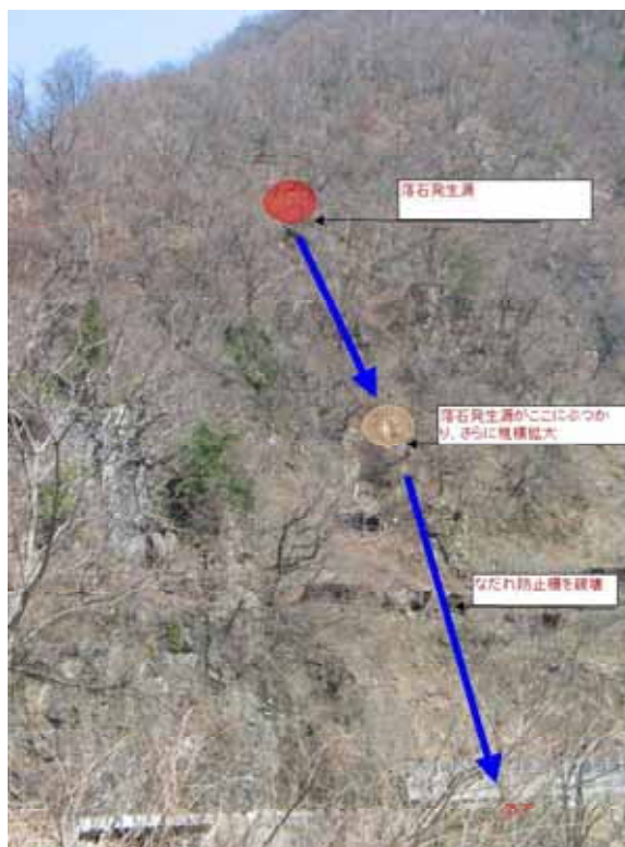
大コロ地区斜面全景
