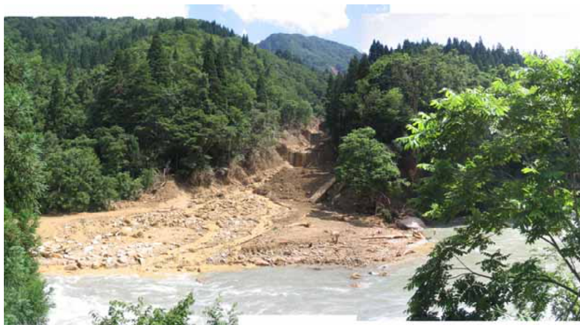
蛇谷土石流災害(被災堰堤・床固工復旧を含む溪間工20基の計画・設計)
