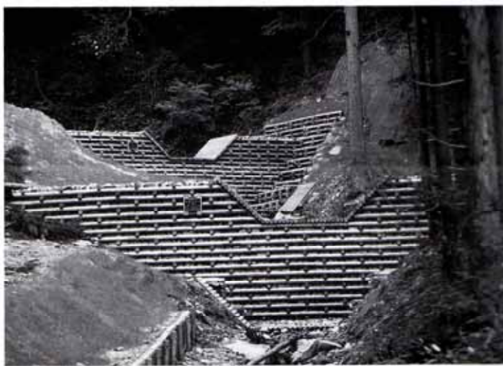
酒見地内木製堰堤工
