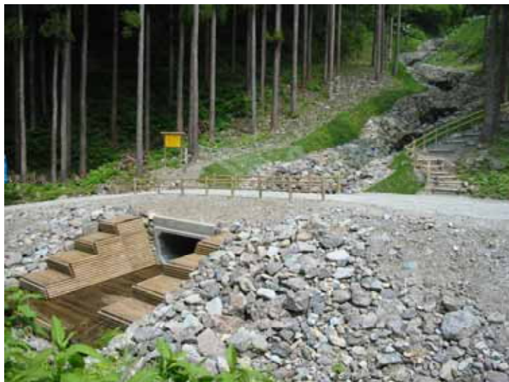
環境防災林整備事業(杉水町地内) 自然石を用いた流路工
