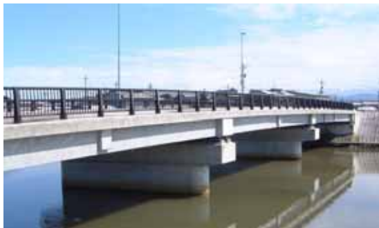
▲ 3 径間 P C プレテン連結 T 桁 ( 小松市 )
