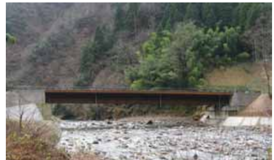
▲ 単純合成鈹桁 ( 合成床版 ) ( 金間大橋 )
