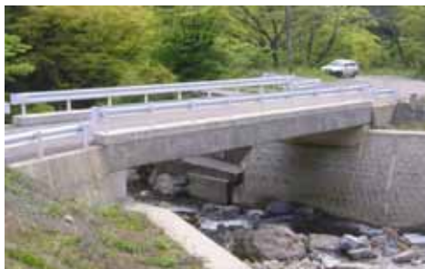
▲イーリースラブ橋（鳥越橋）
