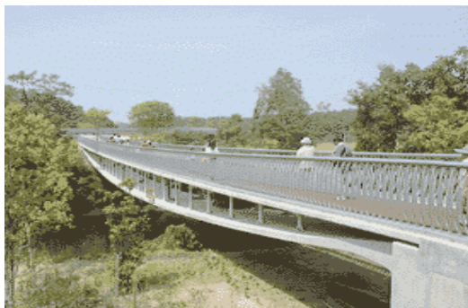
▲石川動物園ゆめ吊橋
