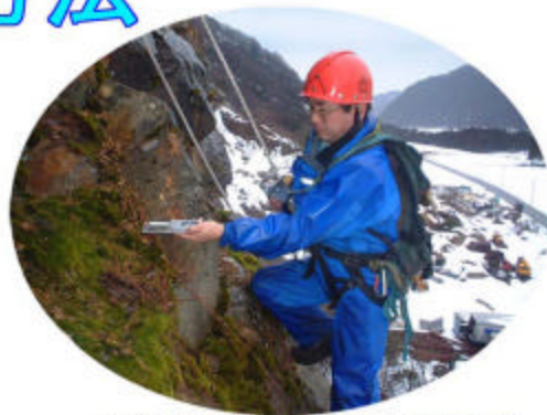
岩盤の亀裂や節理の走向・傾斜を計測し、岩塊の規模や形状を推定します。
