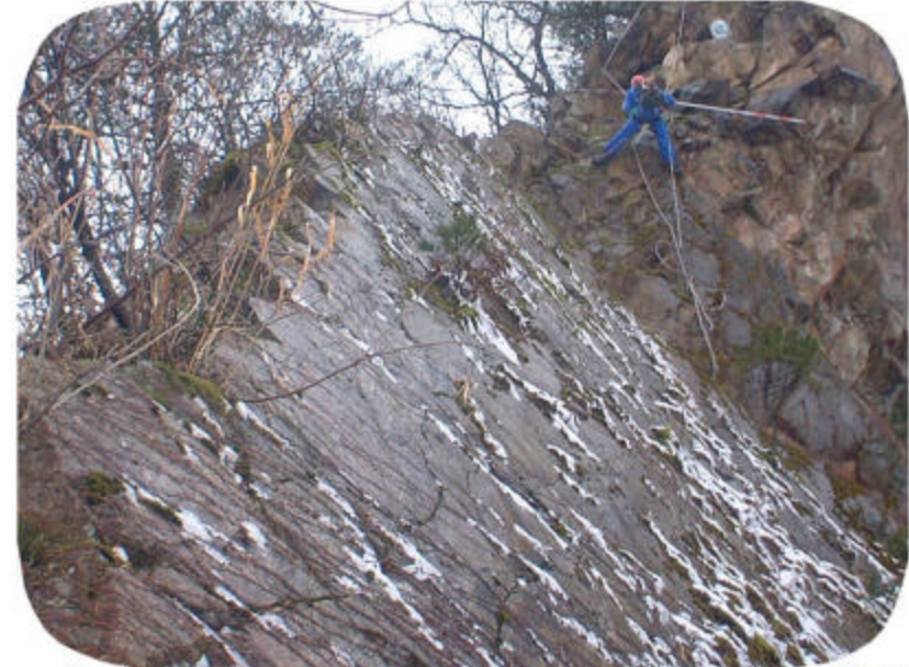
このような岩壁においても、調査しています。
